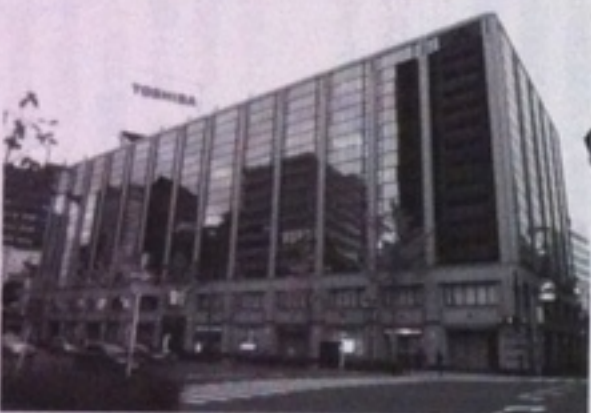
西村隆志弁護士事務所は大阪のメインストリート御堂筋に面した堂島ビルディング内にある
